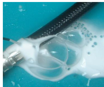
エア漏れ箇所が発泡した状態
